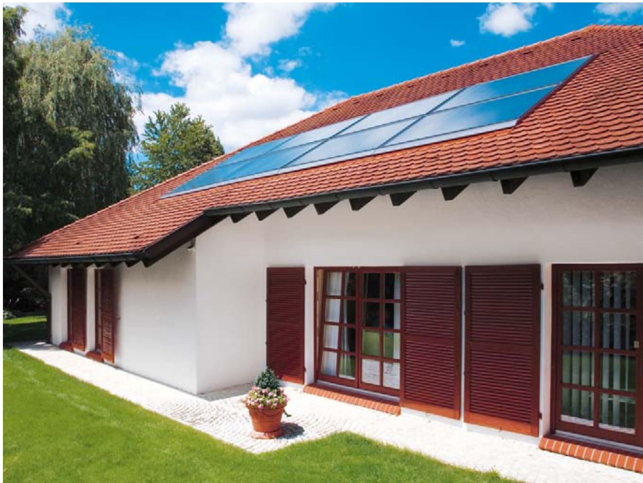
Collettori solari per la preparazione di acqua calda sanitaria e l'integrazione al riscaldamento
